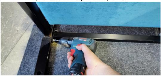
После протяжки винтов монтируем кресло к полу (по необходимости) и закрываем отверстия в опоре кресла декоративными заглушками:
